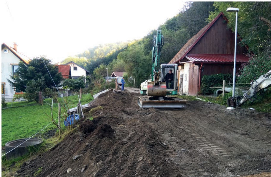
Izgradnja kanalizacije in ureditev ceste Pod gorj
